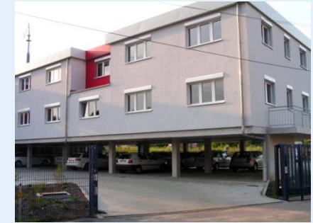
Hochwasserangepasste Bauweise, © Peter Seifert
