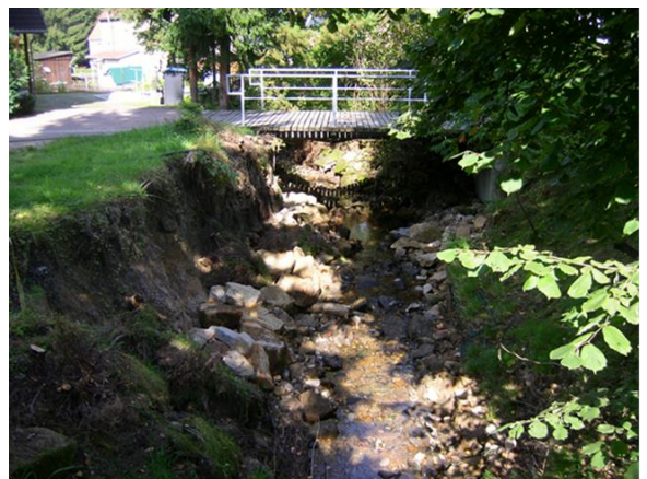
Škoda na svahu vodního toku Struppenbach (fotografie ECOSYSTEM SAXONIA 2010)
